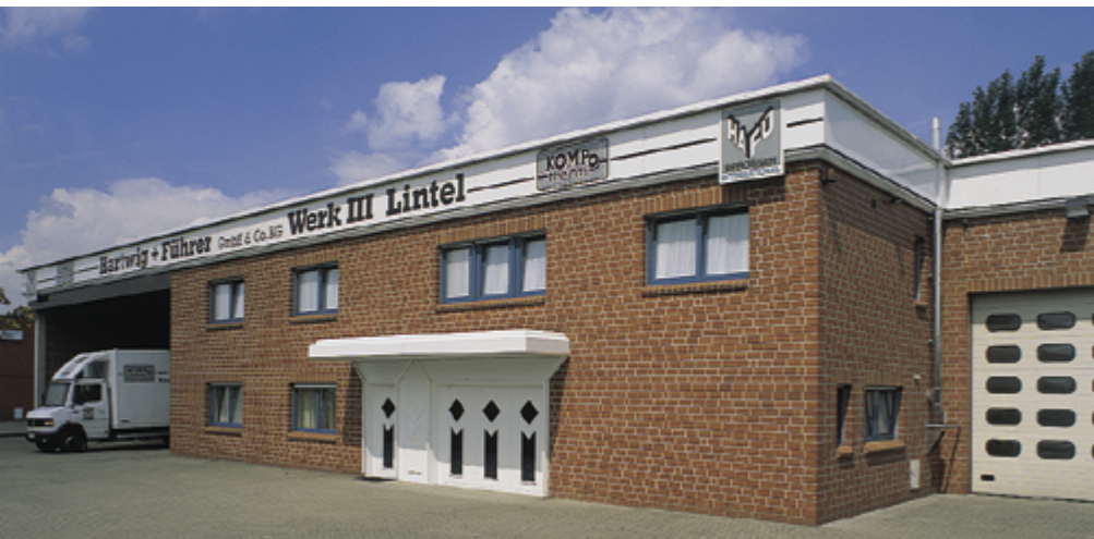
Produktionsstätte Rheda-Wiedenbrück, Ortsteil Lintel
